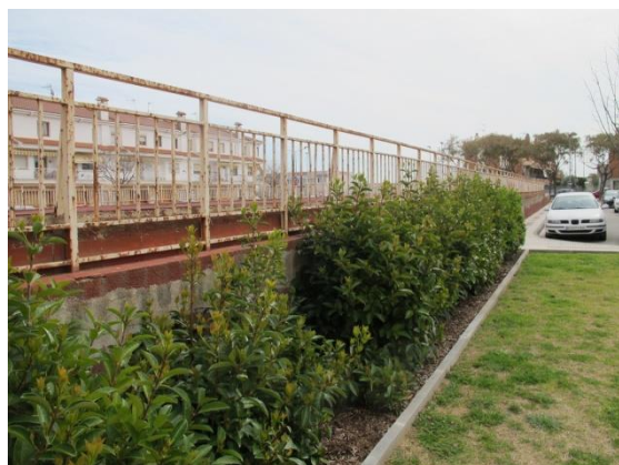
Plaça de la Pagesia. Tanca Sostre aparcament
