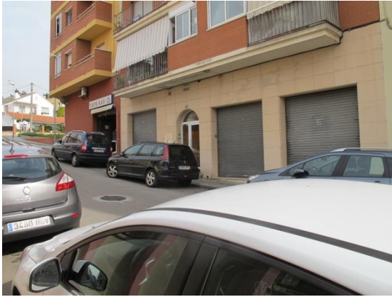
Sector nord. Eixamplament de voreres Endreçament
